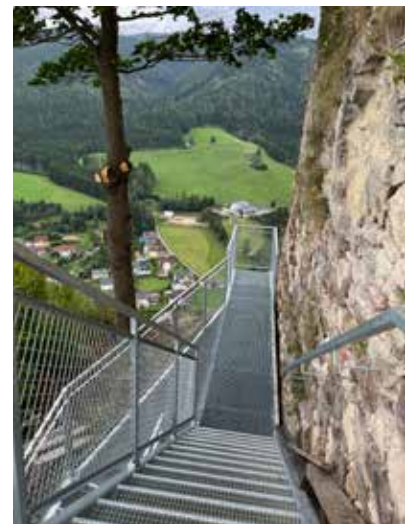
Maßnahmen auf der Burgruine Eppenstein
