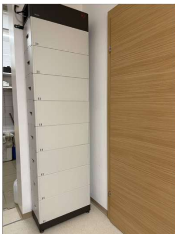
Stromspeicher 22,7 kWh
